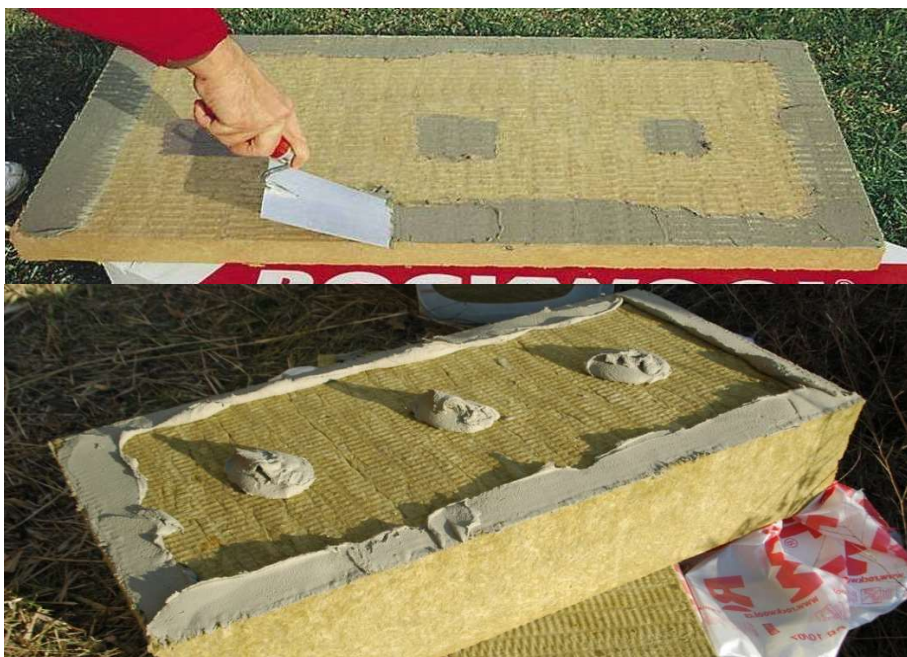
Obr. 4: Nanášení lepicí hmoty pomocí obvodového pásku
